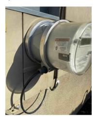
ConnectDER Solar Meter Socket Adapter
