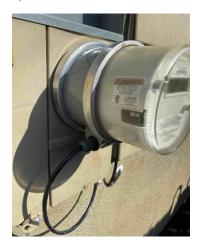
ConnectDER Solar Meter Socket Adapter
